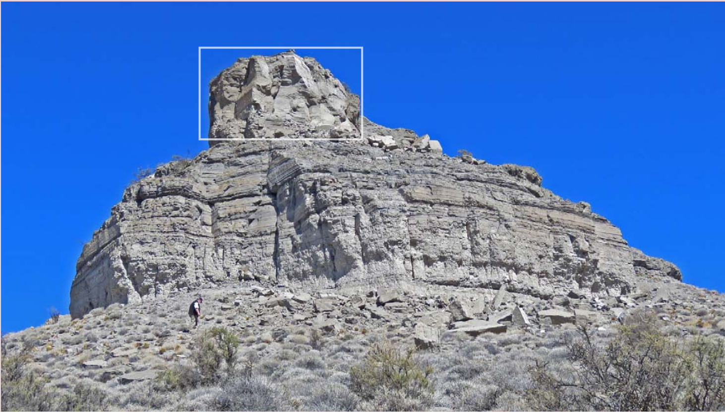
Sector desmoronado. Se observan los bloques colgados todavía en el en el filo del paredón y los bloques caídos sobre el talud.
